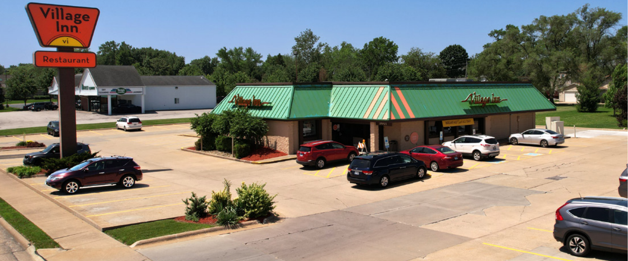
Actual Site Photo
